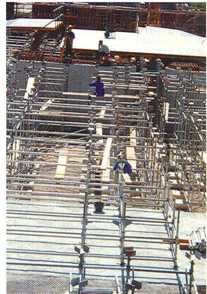
Radovi na montaži skele
