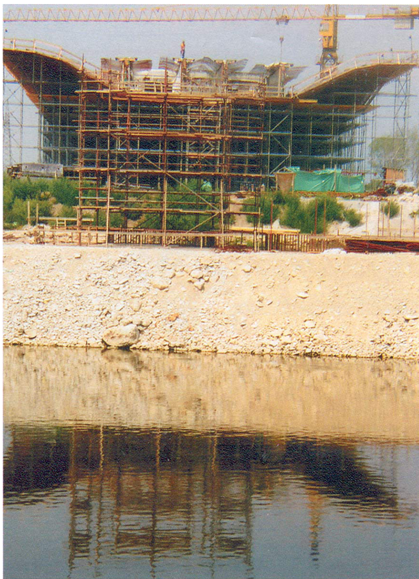
Pogled na gradilište na desnoj obali
