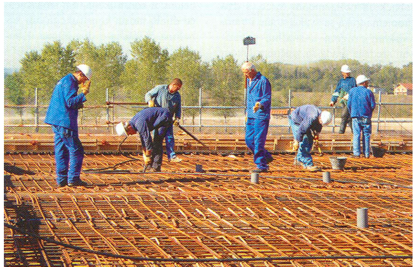
Radovi na betoniranju armiranobetonske konstrukcije
